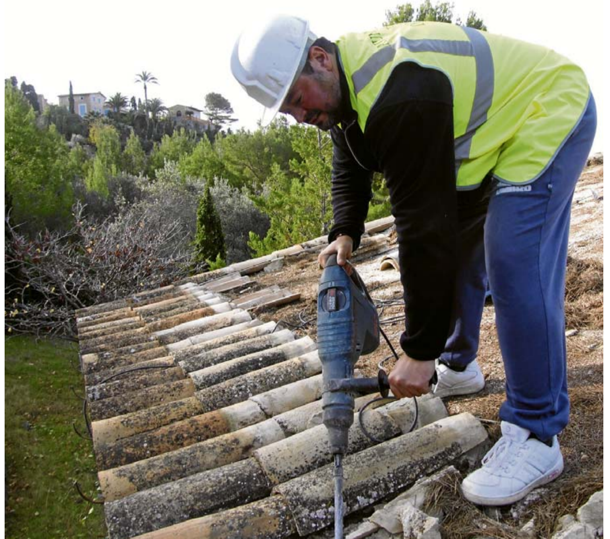
Das gilt es zu verhindern: Abriss einer Villa in Llucalari. In diesem Fall legte sogar der Bürgermeister selbst Hand an – ihm waren zuvor Geldbußen auferlegt worden, weil er den Abriss hinausgezögert hatte. FOTO: J. MORA
